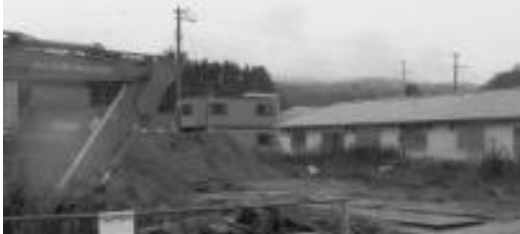
建設中の南清水沢 萌（めばえ）団地
